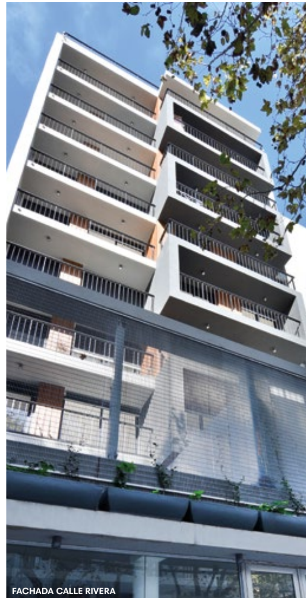
FACHADA CALLE RIVERA
